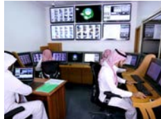
أنظمة سكادا SCADA Systems
